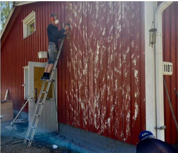
Kalle Lahtinen seinää raaputtamassa ennen maalausta.
