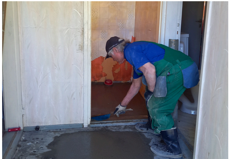
Olli Lehto valaa lattiaa.
