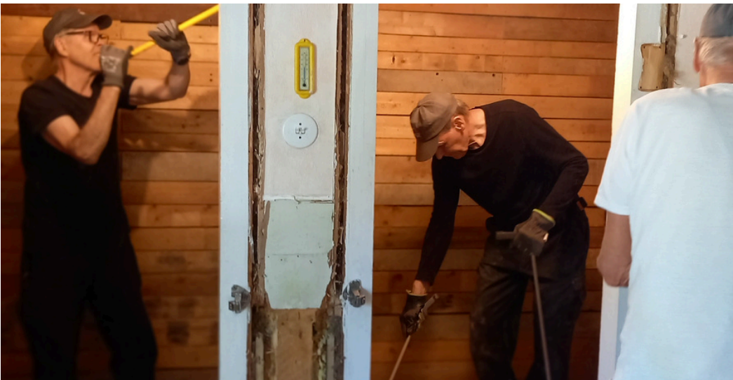
Kylmiön purkua: Matti Åkerlind, Tapio Konttila ja Pekka Rantakallio.
