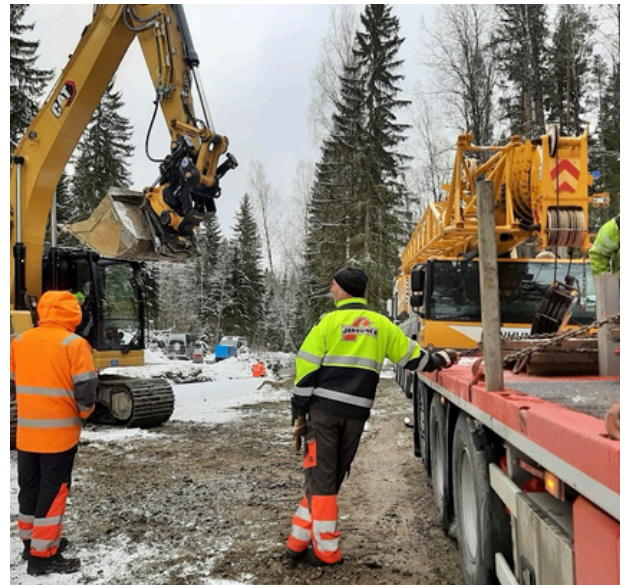
11.3. Kallioniementien siltarumpu asennettiin.
